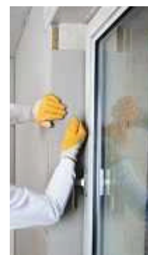
Durch die Kombination von Steinwolle mit Aerogelen erreicht dieses Innendämmssystem eine gegenüber reiner Steinwolle verbesserte Wärmedämmung. Bild: Deutsche Rockwool
