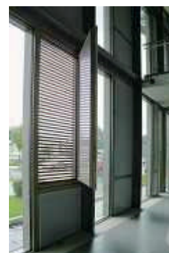
Bei vorgefertigten Fassadenelementen ermöglichen Vakuum-Isolationspaneele geringe Bauteildicken. Bild: Autor
