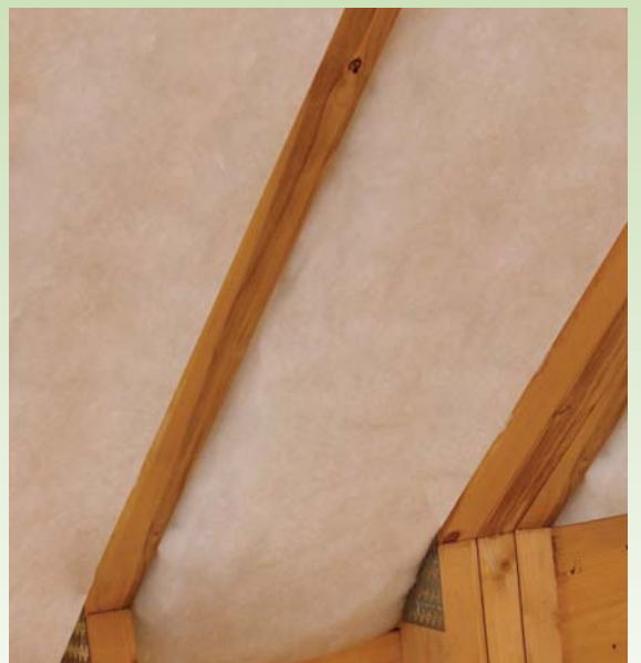
Toepassing plaat in schuin dak
